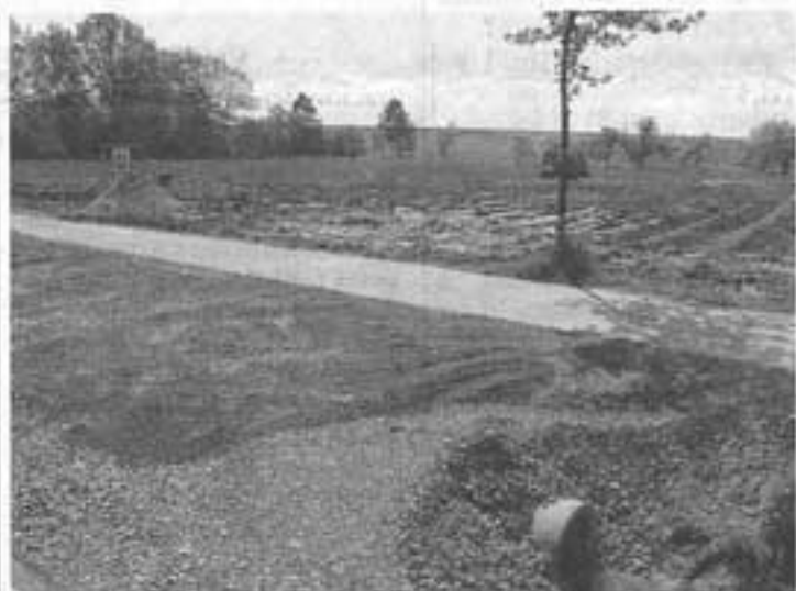
Zufahrt zum neuen VfL-Platz: Die Baustelle darf schon eingerichtet werden, obwohl es noch keine Baugenehmigung gibt. FOTO: ANDREAS ZOBEL
